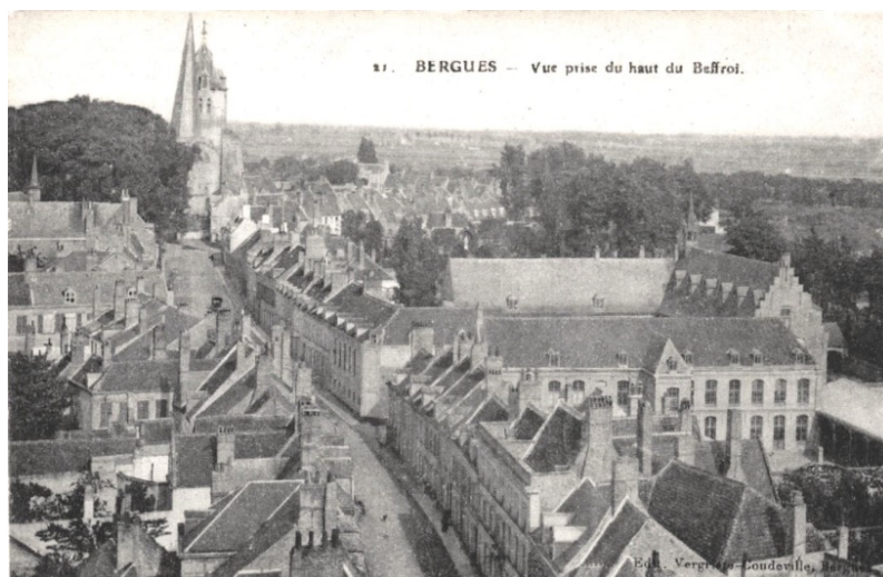
Bergues, vue générale du haut du beffroi
